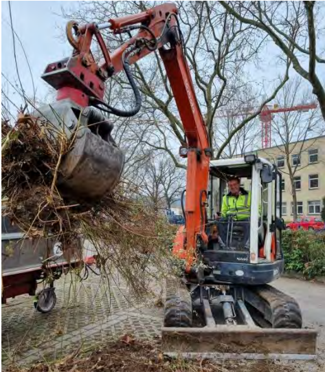
Der Bagger on tour...
